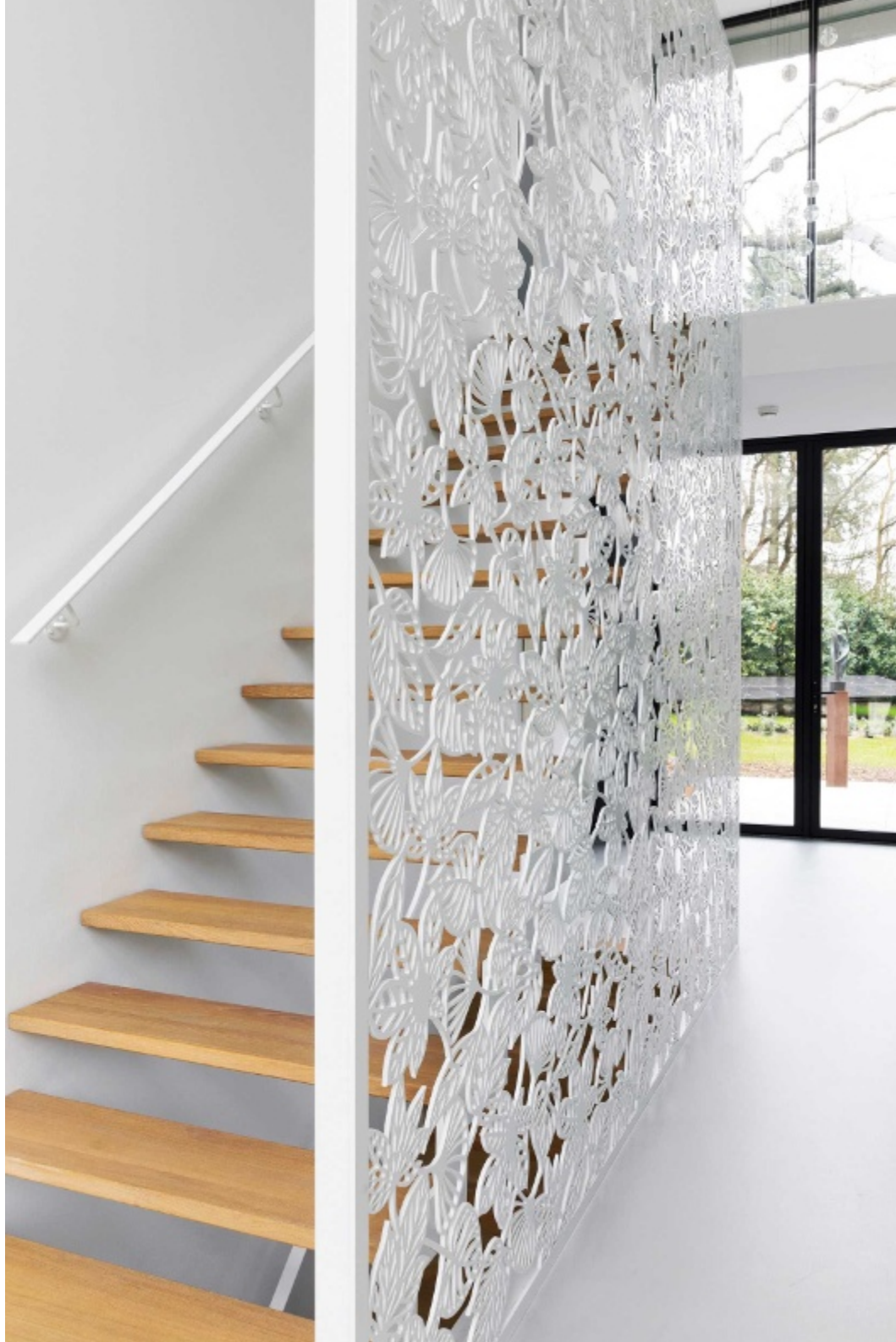
In de acht meter hoge hal is door Kap+Berk een vier meter hoge balustrade ontworpen van gelaserd staal. Dit werk werd uitgevoerd door Metaluniek Staalspecialisten.
